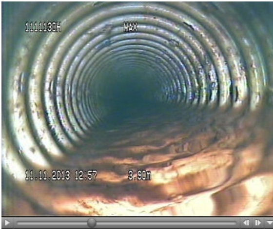
Figuur 5 Goede ontwatering door drain, geïnstalleerd in Texelse zeelei (foto: L C P M Stuyt, 11 november 2013)
