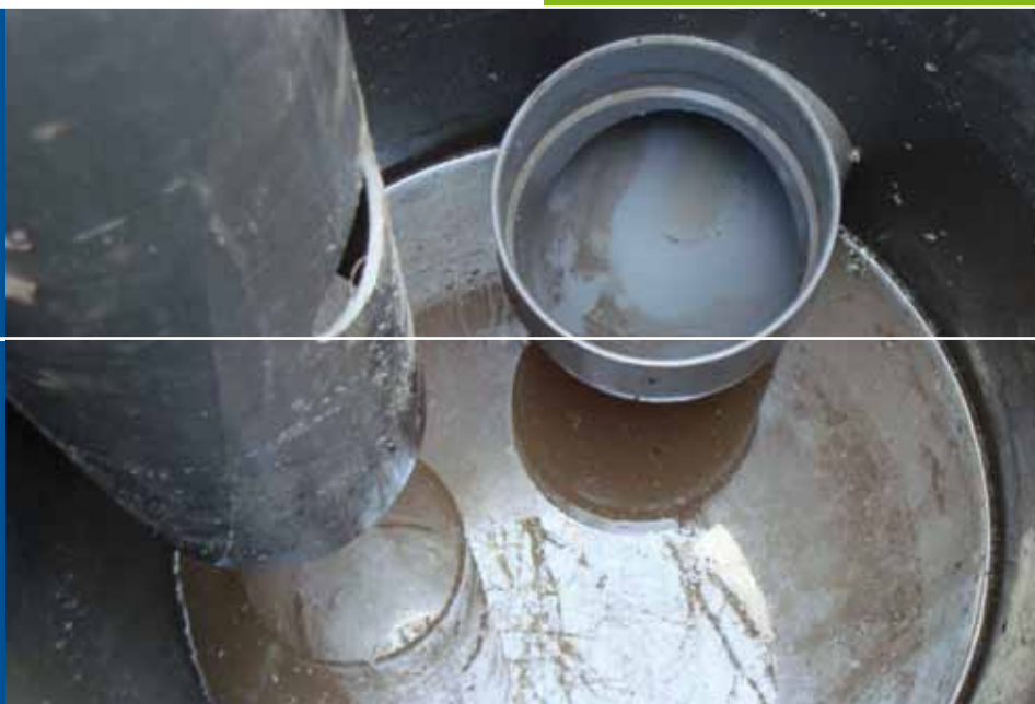
Niveauput peilgestuurde drainage
